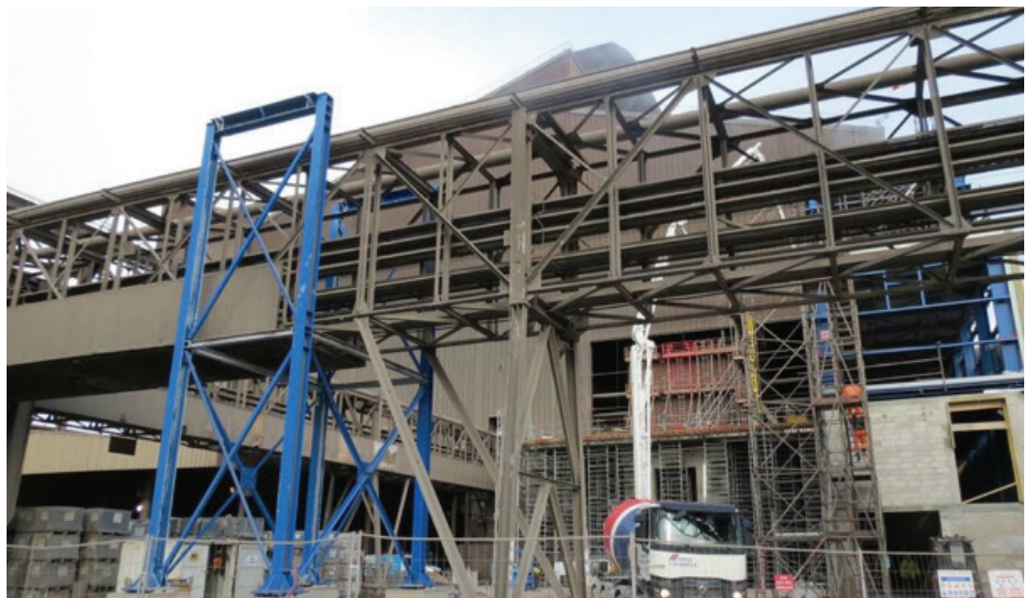
Four poche ArcelorMittal Fos sur mer.
